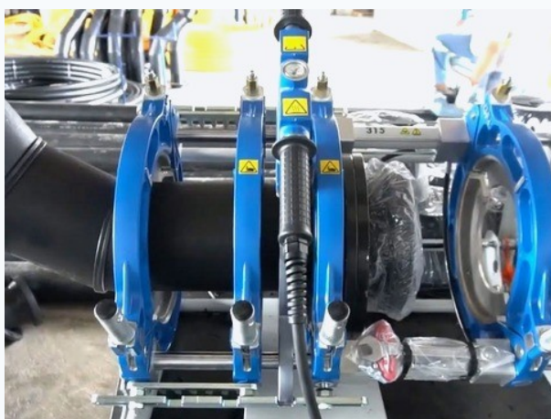
Eletrofusão em rede industrial
